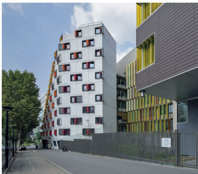
Résidence étudiante de 4000 m 2 avec 130 chambres, boulevard d'Indochine, Paris 19 e (Moussafir Architectes Associés)
