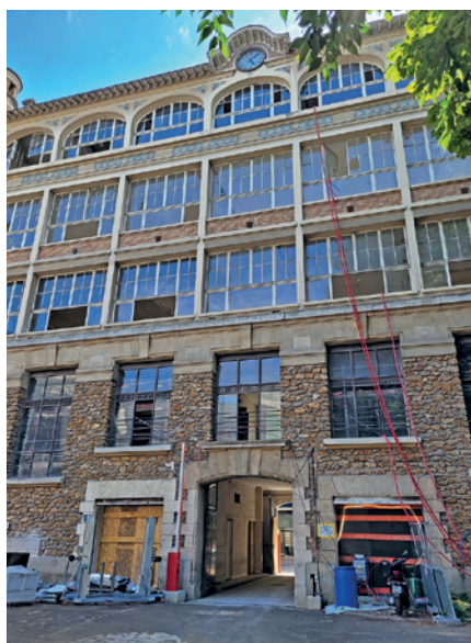
Galileo Global Education s'installera en 2025 au cœur du 5 e arrondissement de Paris dans les anciens bâtiments d'AgroParisTech (chantier du promoteur Hertel).
