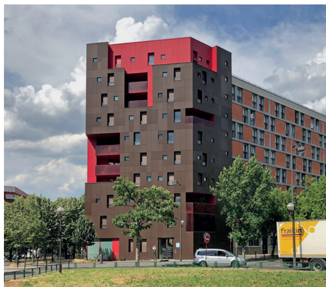
La résidence étudiante Docteur Yersin, Le Tétris, compte 54 chambres, Paris 13 e (architectes C. Ouhayoun et N. Ziesel de l'agence d'architecture Koz)
