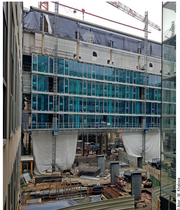
Travaux de rénovation et d'agrandissement de l'université Paris Dauphine-PSL, Paris 16 e
